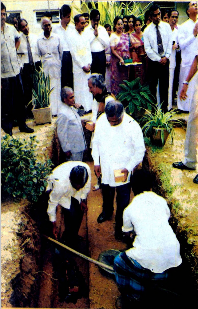
මහනුවර මහජන පුස්තකාලය සඳහා නව පුස්තකාල ගොඩනැගිල්ලකට මුල්ගල තැබීම තත්කල්, ගොනු ප්‍රාසංග සිතුවම් පිටිවීම තත්කල්. චිත්‍රපටය නිර්මාණය කිරීම Laying of Foundation Stone for a new building for the Public Library, Kandy. 1995.10.01
